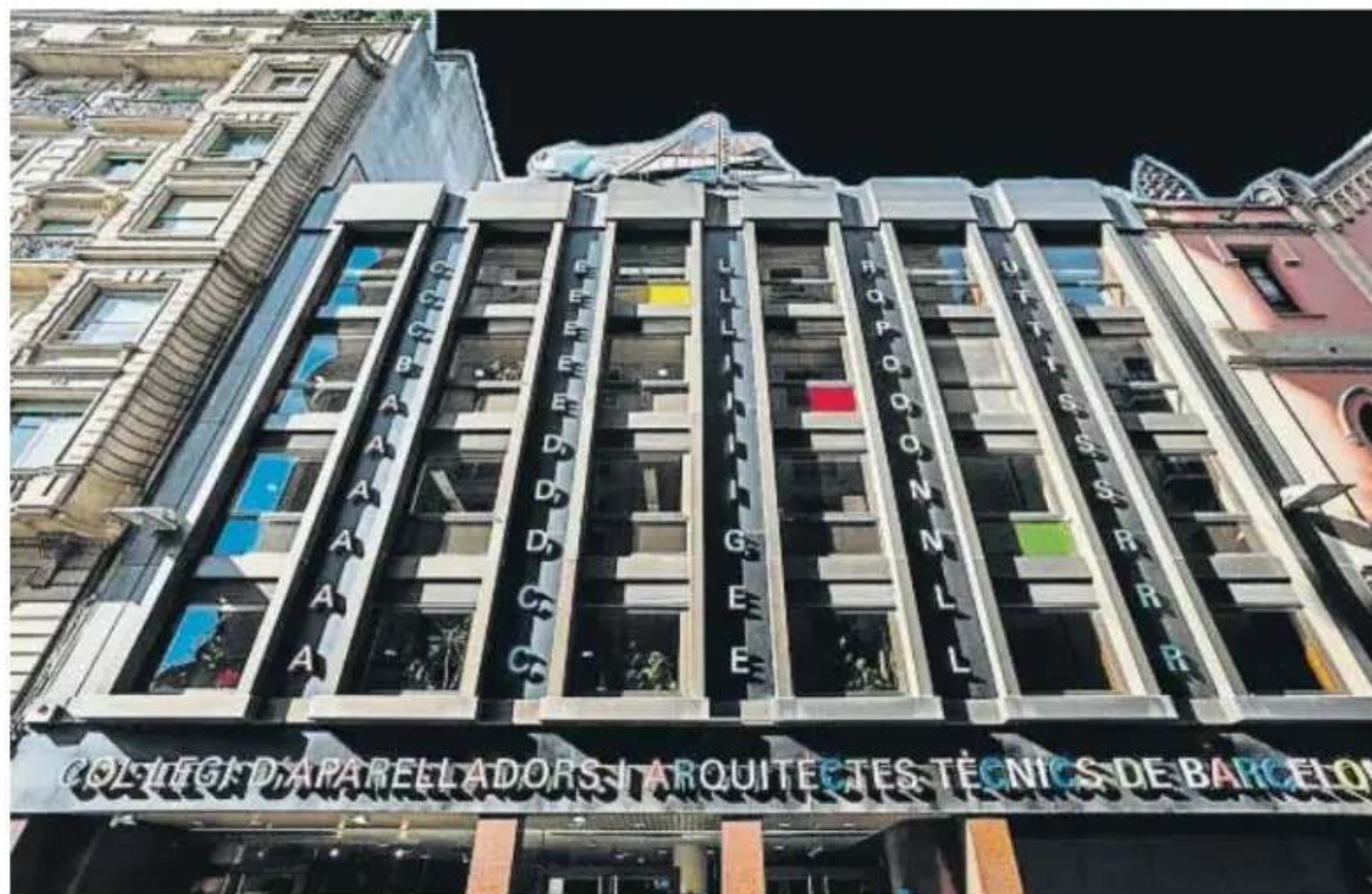
La imagen que ofrecía la misma fachada antes de la intervención que está a punto de culminar
